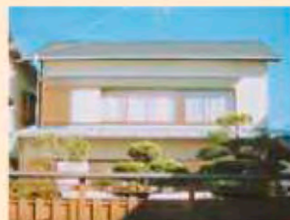
補強後 化粧スレート葺きの軽い屋根に改修しました。
