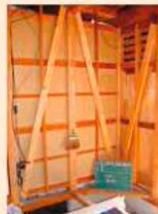
1階に新設した筋かい
