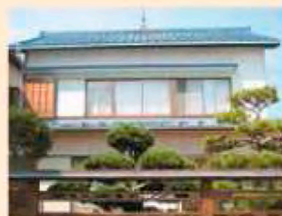
補強前 2階の屋根は瓦葺きの重い屋根でした。
